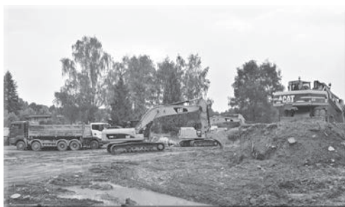
Příprava na sanaci
